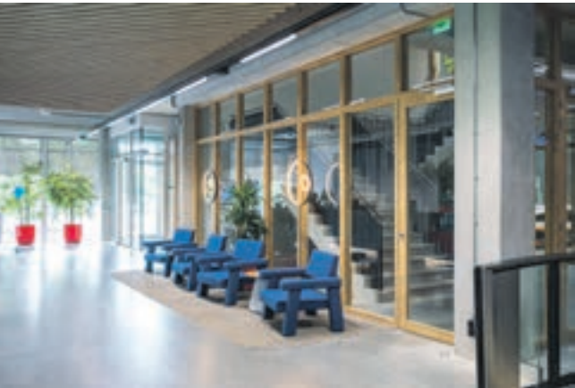
Alle beglazing werd geïnstalleerd met houten kozijnen, waardoor het projectteam de authentieke industriële esthetiek van het gebouw kon behouden en verfijnen.
