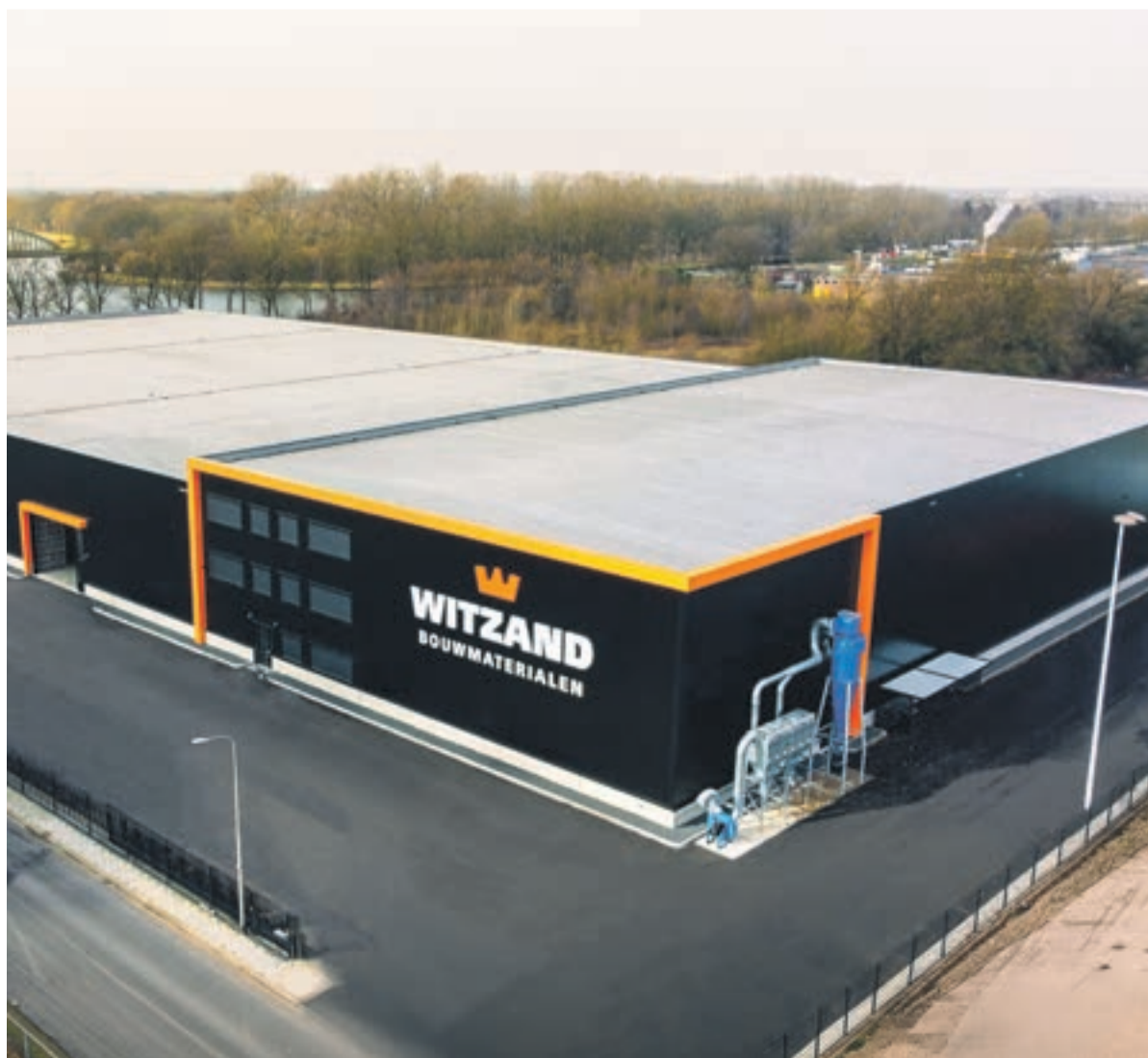
Witzand Bouwmaterialen nam vorig jaar een nieuw pand in gebruik aan de Van Maasdijkweg in Almelo.
